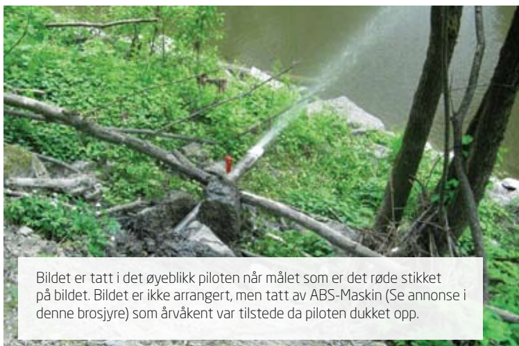
Her peiles dybde og fall og data kommuniseres til boreoperatør via radiokommunikasjon.
